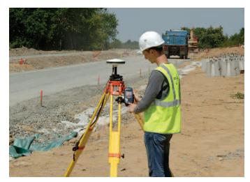
Con ProMark3, los levantamientos de tipo Stop & Go se simplifican. La portabilidad y la interfaz de fácil uso, permiten a un operador solo realizar levantamientos rápidos y confiables.
