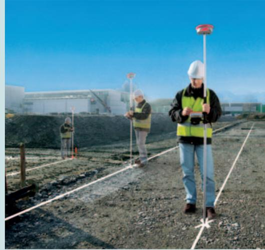
Replanteo de puntos y modelos digitales del terreno (MDT) utilizando el programa Replanteo. Navegue directamente utilizando la opción gráfica para vista de planos o el nivel esférico incorporado.
