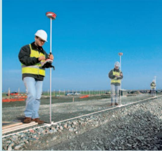
Replanteo y medición de líneas y arcos. Introducción de desplazamientos y alturas. Definición de líneas de control y referencia utilizando la opción gráfica para vista de planos. Definición de parámetros para control de calidad. Ideal para edificación, drenaje, cimientos, etc.
